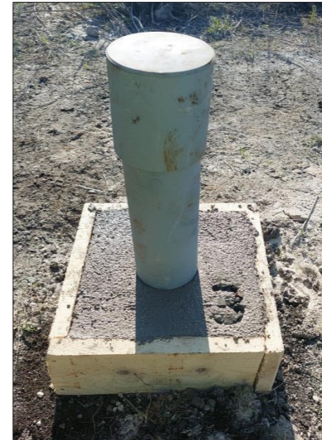
Fotografija 5: Čelični poklopac na istražnoj bušotini BH-3
